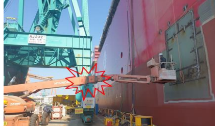
[사진4. Crane, 고소차 충돌 사고]
